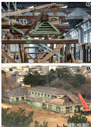
①側面から見た屋根部。②現代建築では珍しい木製のガラリ(通気口)。③研究実験棟1でレトロなバスターグリーンを扉を支える林研究室の高原柚さん(右)と腰原研究室の富士本学さん。④解体時の共通講座第三教室第一棟(2022年)。クレーンの向かいが輪切り部。⑤1942年当時の図面。⑥当時の図面と部材を元にして組まれた輪切り部の模型(奥が茶室)。⑦「生研パビリオン」のイメージ図。
